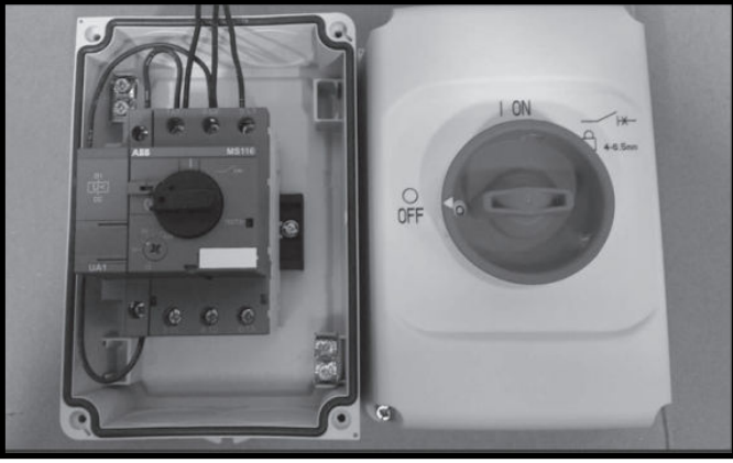
Şekil 4. Sol: İzolatörün iç (sol) ve dış (sağ) görünümü. Sağ: İzolatör için terminal bağlantılarını gösteren şematik bir
